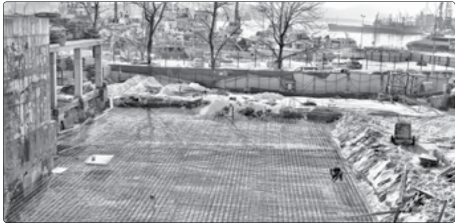
На снимке: заливка стиловатой части
